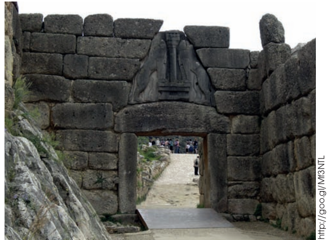
■ Puerta de los Leones, datada en torno al año 1350 a. C. Perteneció a la muralla ciclópea de Micenas, construida con enormes bloques de piedra
